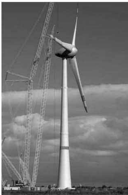
شکل (۶): نمائی از مراحل نصب توربین با بالاترین ظرفیت (+۷ MW)
