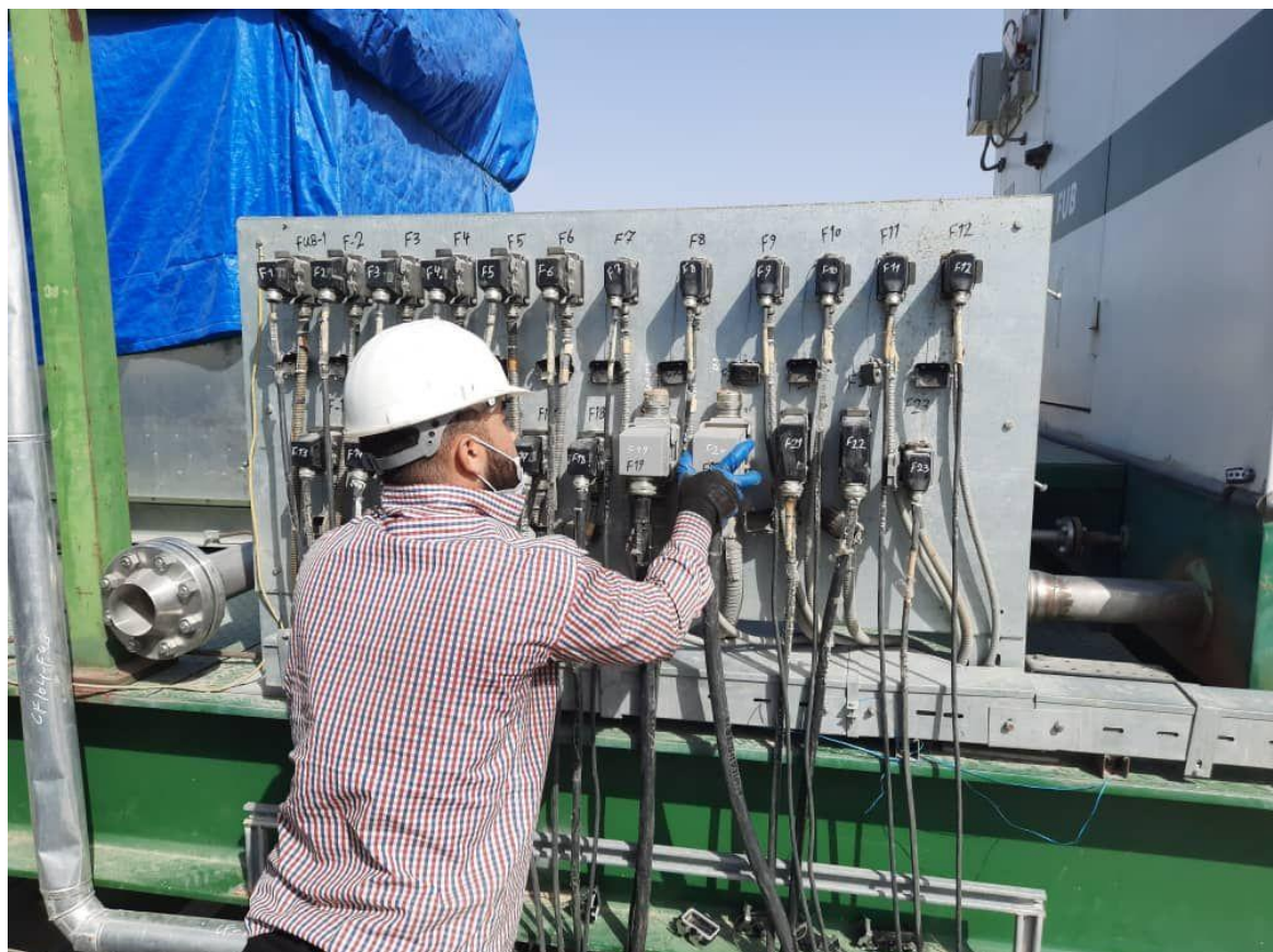
اتمام نصب کابل‌های سوکت به سوکت از EEM1 به FUB
