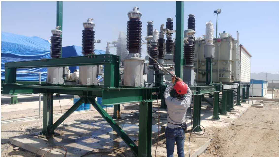
شروع کابل کشی و کانکشن سوکت به سوکت از پشت EEM1 به FUB
