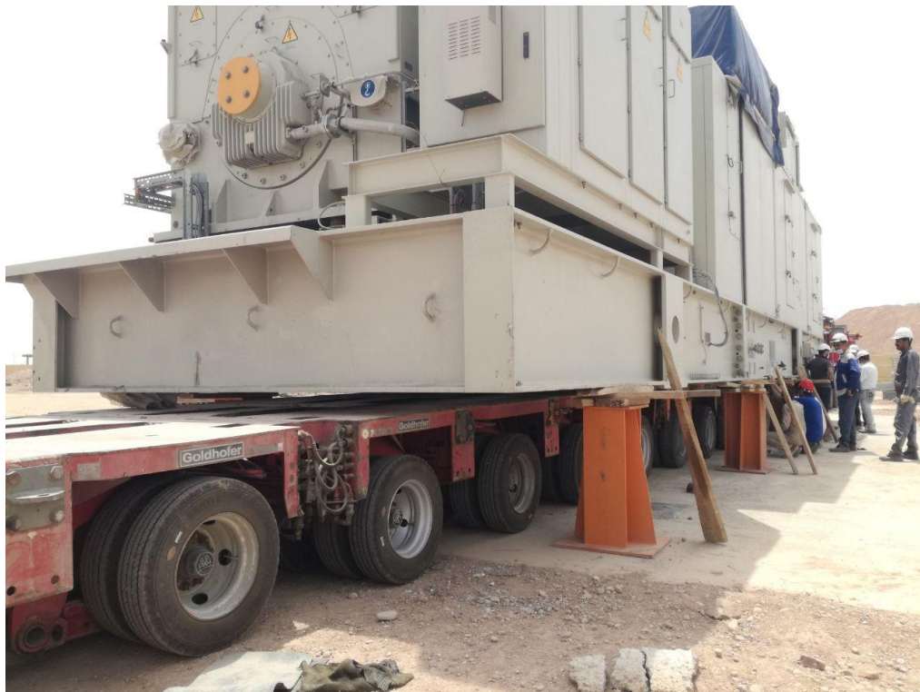
روز یکشنبه ۱۴۰۰/۰۳/۰۲ توربوژنراتور GTG4 بر روی پایه های موقت نصب گردید
