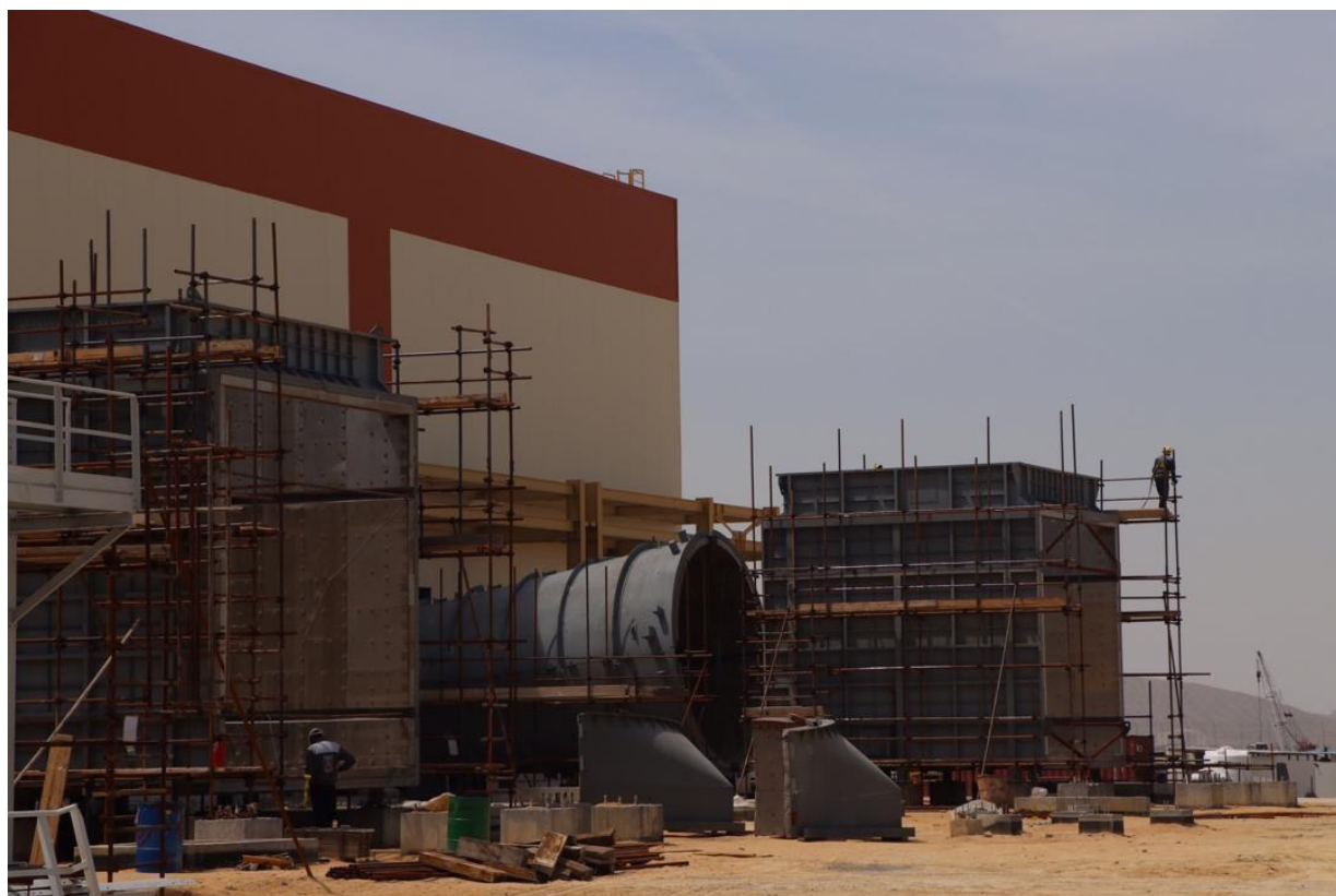
*جوشکاری لاور به آپر واحد ۲ گازی
