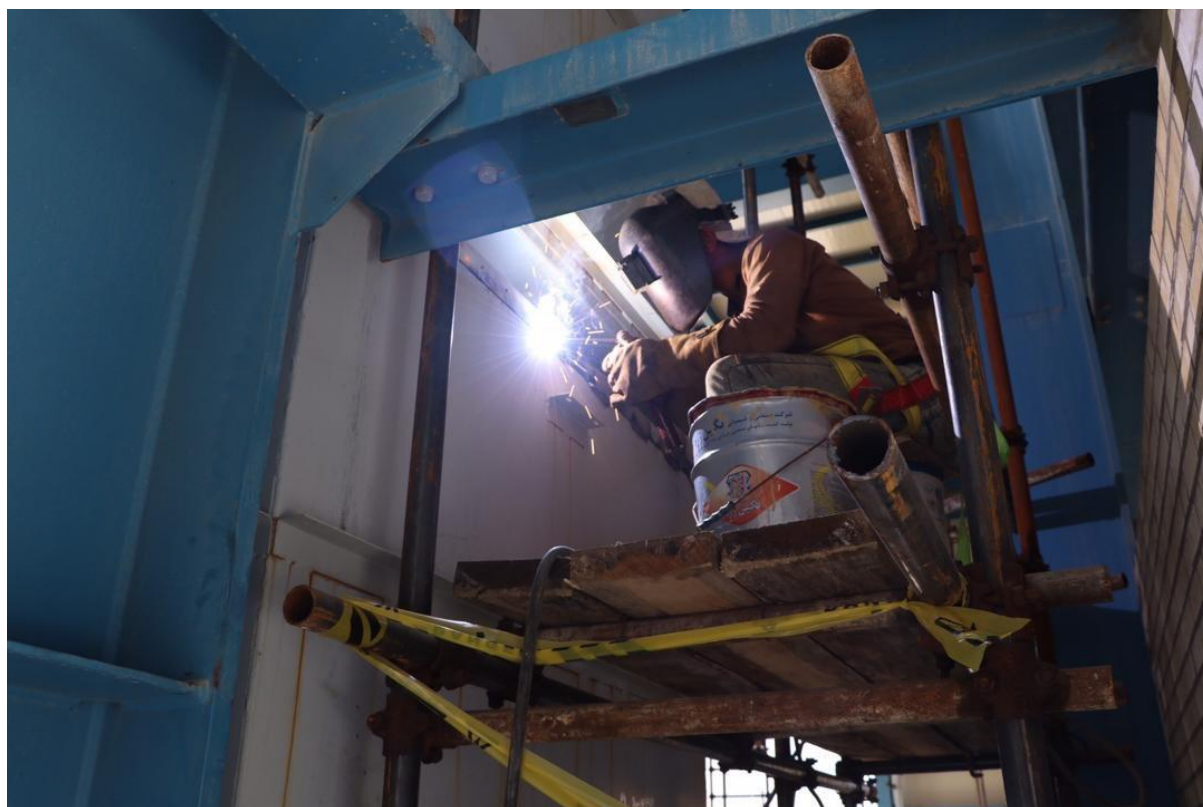
*جوشکاری لاور به آپر واحد ۲ گازی
